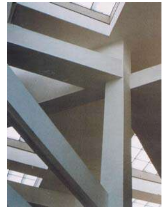
60. Casa III: estrutura
