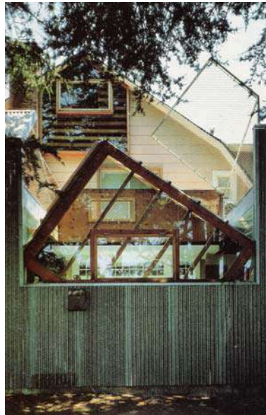
110. Muro e janela da cozinha
